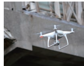
建物外観の調査状況
