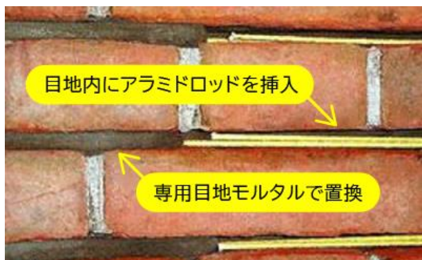
B-Star工法 (アラミドロッドによる煉瓦目地置換補強工法)
