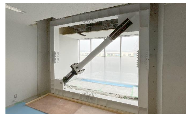
フルード粘性ダンパー (シリコン流体を使用した制振装置)
