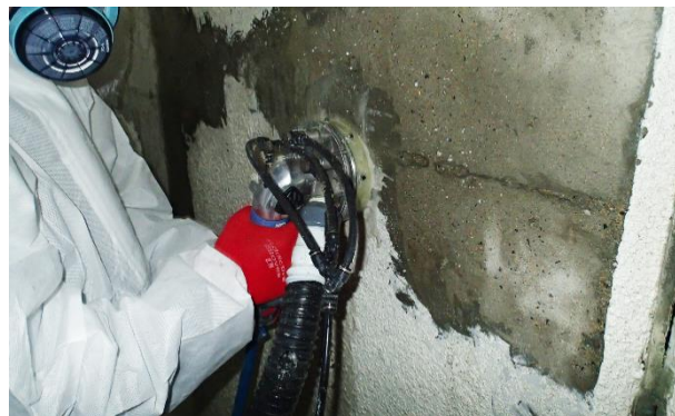
AGバブルシステム(石綿含有仕上 塗材・下地材の撤去工法)
