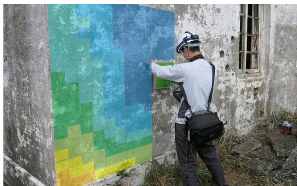
鉄筋腐食調査
